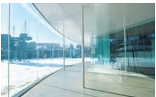
07 外壁のガラス Wall
